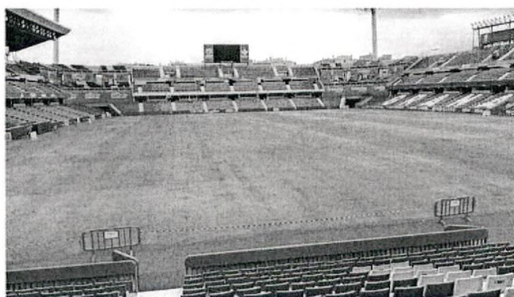
Aspecto del campo durante los trabajos
